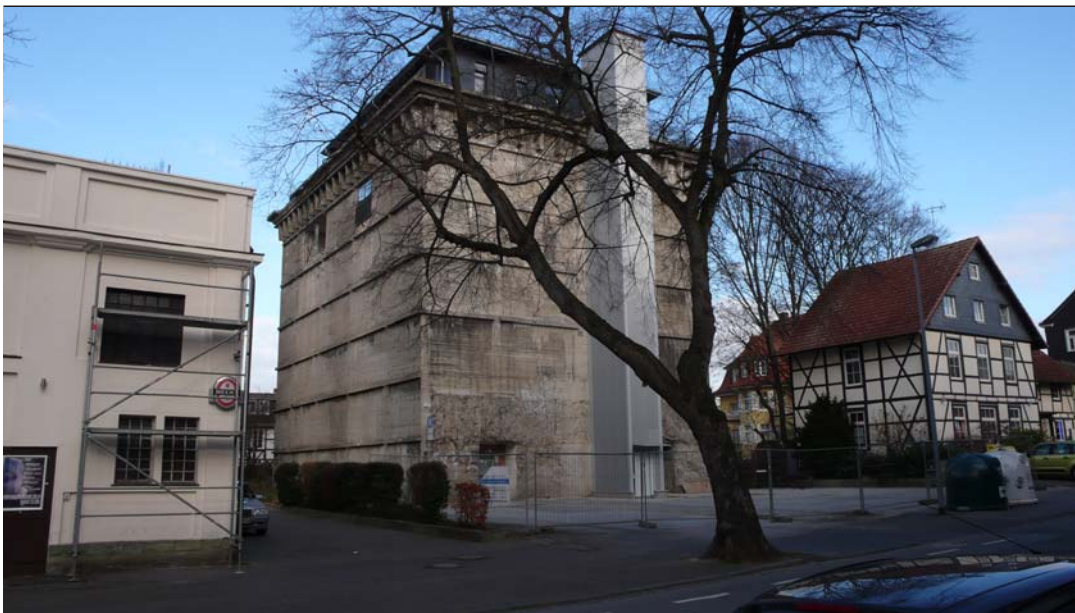
Straßenansicht mit Aufzug und Staffelgeschoss - Februar 2014
