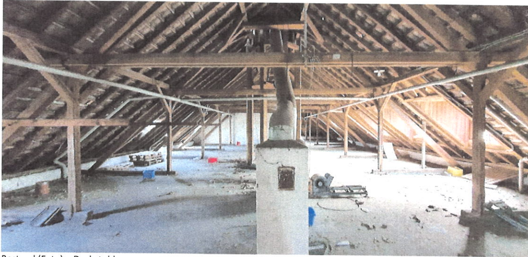
Bestand (Foto) – Dachstuhl
